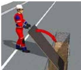
**Assembler les vérins** hors de la fouille puis les positionner (emploi d'une griffe auxiliaire)
