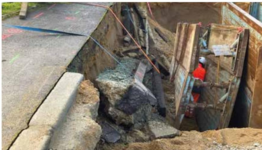
Recommandation : pour ne pas fragiliser les sols en bordure de la future tranchée, il est conseillé d'effectuer les sondages des réseaux croisés dans l'axe du réseau à poser.
