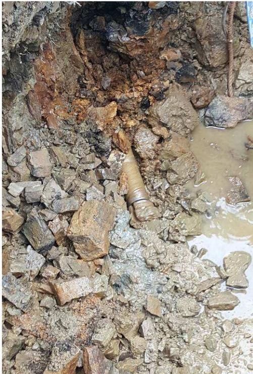
Après 12 mètres de tir pilote dans le schiste avec au milieu une poche de terre de 3 m de longueur, la TERRA-ROCK 65 arrive à sa cible.
