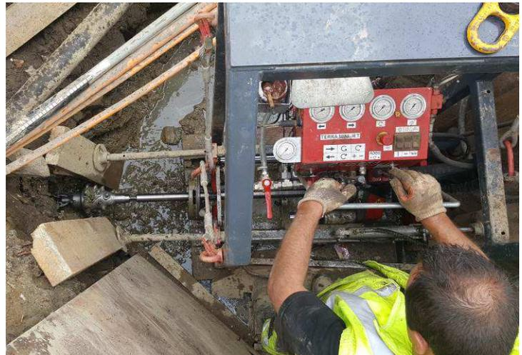
Ensuite l'aléreur ROCK 170 R a été renvoyé dans le tunnel avec cette fois le fourreau PEHD pour les deux gaines de fibre optique DE 50 mm.
