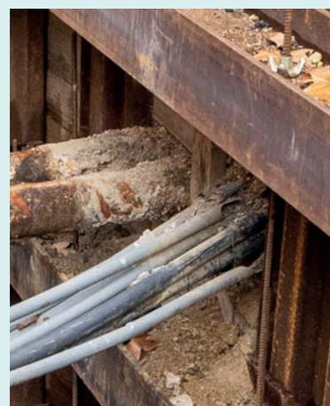
Quelques autres types de protections existent, qui à ce jour ne répondent pas à la norme NF EN 13331-1 « Dispositifs de blindage de tranchées » et ne sont pas assimilés à des blindages. De ce fait il est fortement recommandé de limiter leur utilisation aux fouilles de profondeur inférieures à 1,30 m, pour des chantiers de courte durée.
